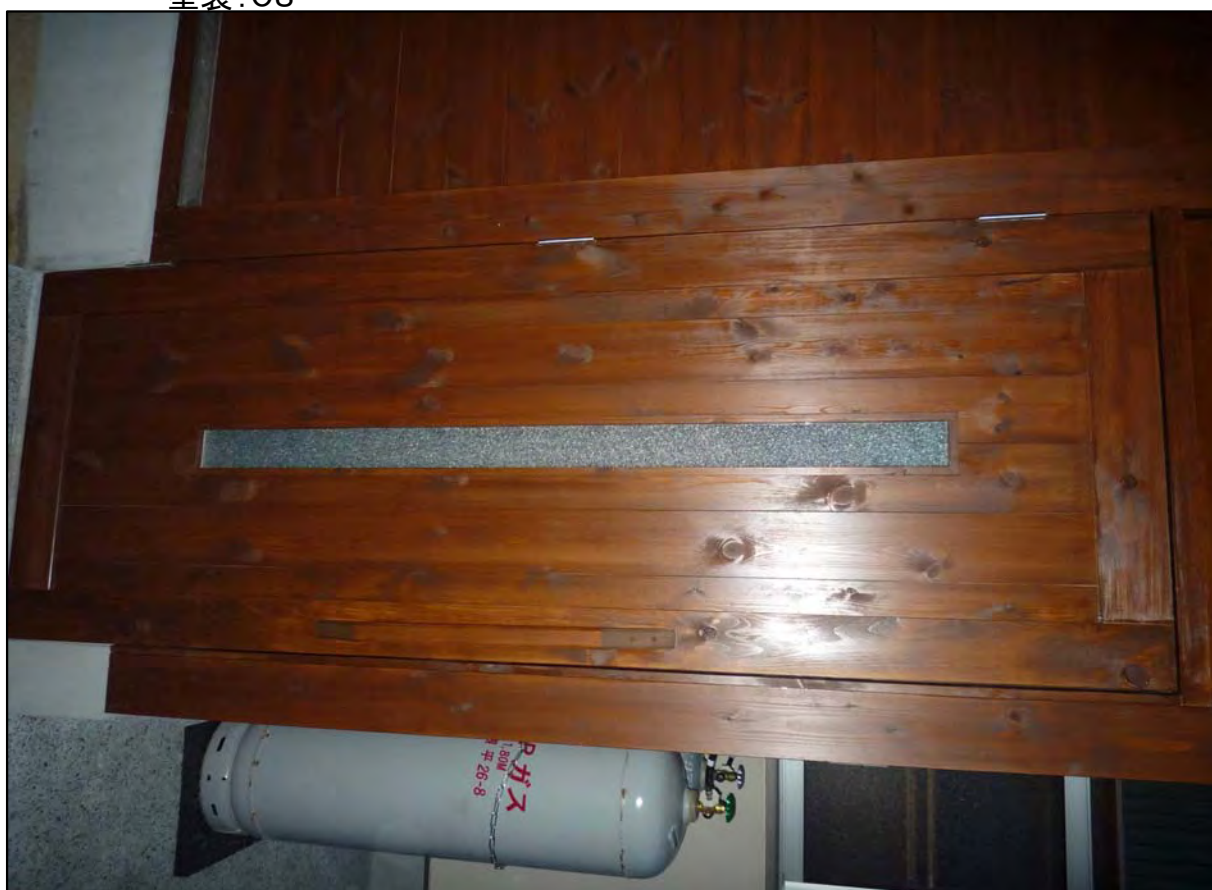
框板戸ガラス入り 片開き 材質: 桧(特一) 板: パイン羽目板 塗装: OS 型ガラス4mm
