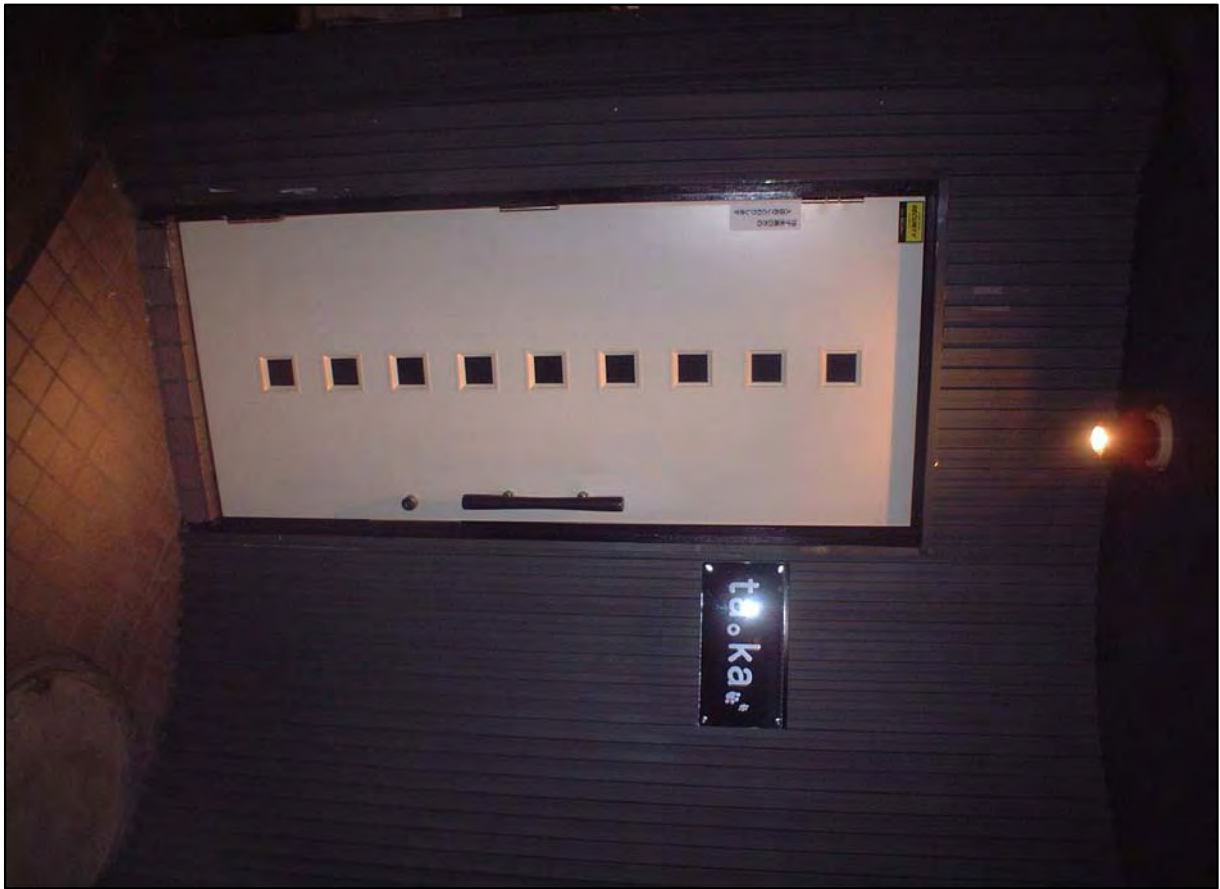
メラミンフラッシュ戸 片開き 材質:メラミン化粧合板 格子ガラス貼り 透明ガラス3mm
