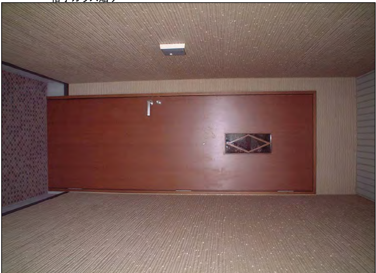
メラミンフラッシュ戸 片開き 材質:メラミン化粧合板 格子ガラス貼り 透明ガラス3mm
