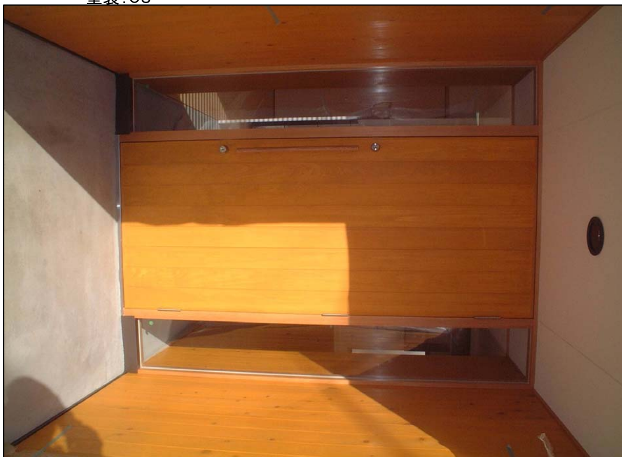
框板戸ガラス入り 片開き 材質: 桧(特一) 板: パイン羽目板 塗装: OS 型ガラス4mm
